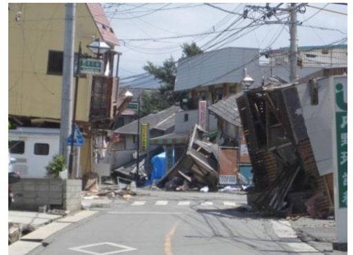
地震で損壊した建物
