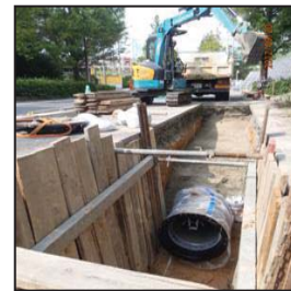
管の布設替工事
