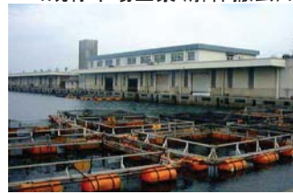
〈既存市場全景(解体撤去)〉
