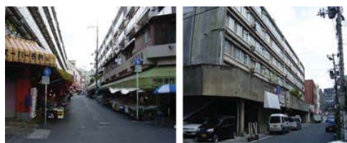
老朽化した竹崎改良住宅
