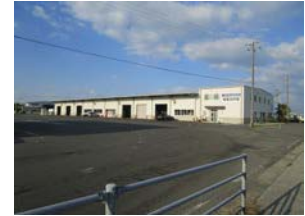
〈仮設荷捌き所〉
