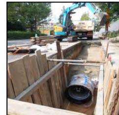
管の布設替工事
