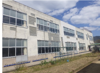
【外壁落下防止処置後】
