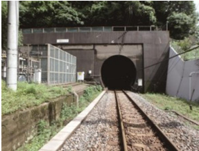
関門隧道下り線 関門隧道上り線
