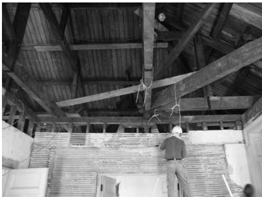
旧下関英国領事館保存修理工事（第 1 期工事）
