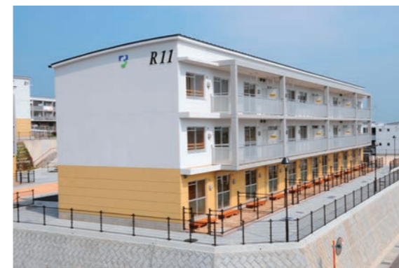
長野古城住宅南側外観R11
