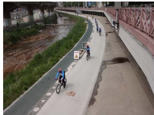
△河川敷に整備された自転車道。
