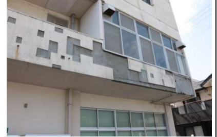
（老朽化が進む安岡公民館）
