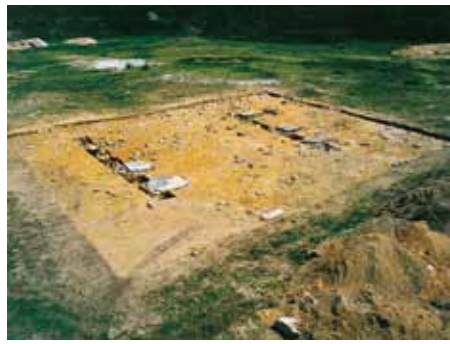
① 本丸殿舎玄関の基礎
