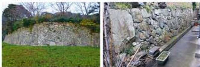
本丸奥西側の石垣 差葉団地にある石積み
