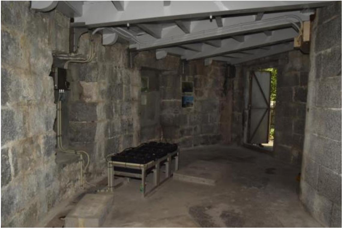
六連島灯台 灯塔付属舎発電機室内部
