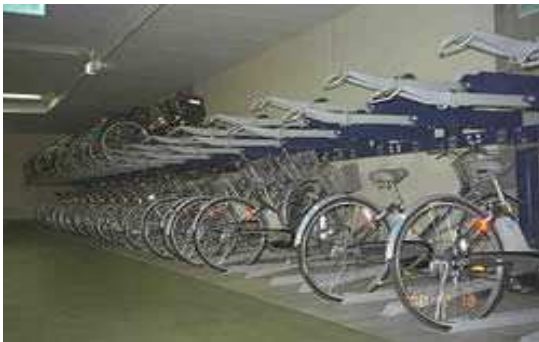
地下駐車場の一部を利用したレンタルサイクルポート
