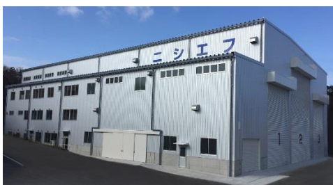
完成した工場
