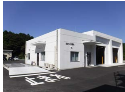
豊北中継貯留槽
