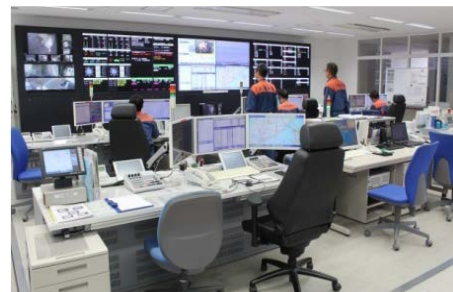
下関市・美祢市高機能消防指令センター
