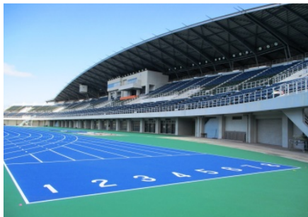
セービング陸上競技場 (下関陸上競技場)
