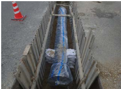
管の布設替工事
