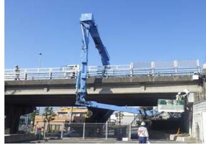
橋りょう点検の様子
