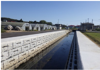
改修工事実施状況
