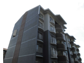
熊野西（現況外観）
