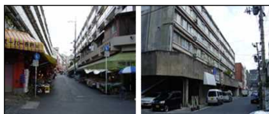
老朽化した竹崎改良住宅
