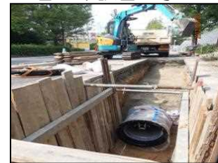
管の布設替工事
