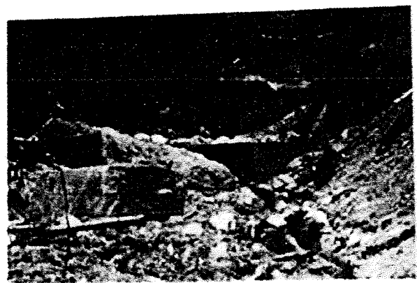
土石流の被害も甚しく、市は緊急に防衛ダムを築くので、
