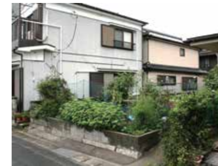
解体後の空き地を家庭菜園
