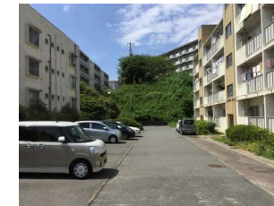
③R8 南側敷地内通路
