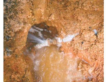
漏水している鉛製給水管
