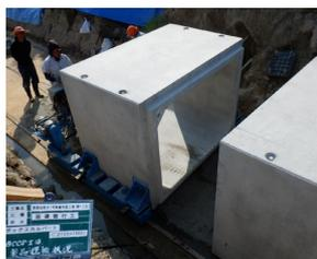
※1 雨水渠の整備は、主にボックスカルバートと呼ばれる箱型のコンクリート構造物を繋げて水路を作ります。
