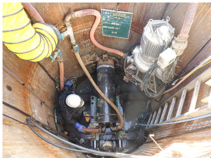
推進工法(立坑内部の様子)
