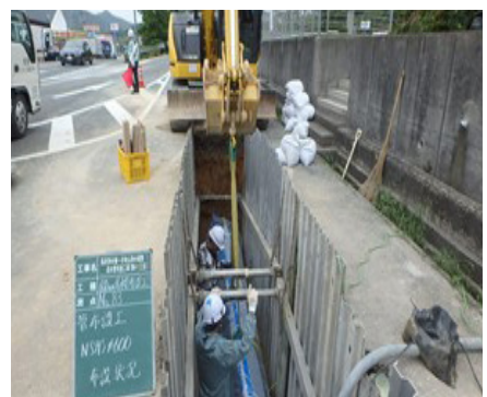
送水管布設工事
