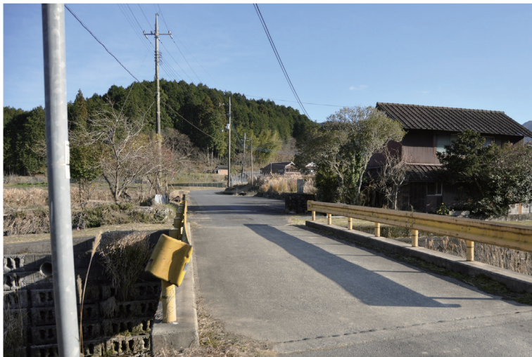
写真19 現在の長井手橋
