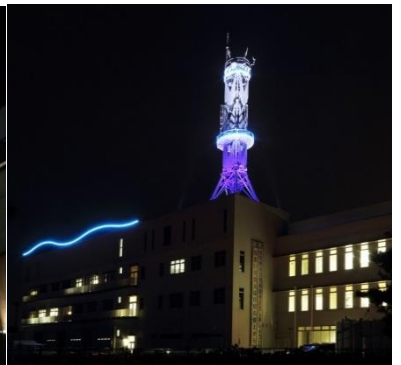
下関市消防局庁舎
