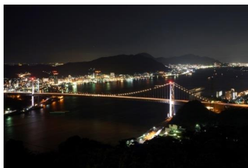
(写真2) 火の山展望台から見た関門橋
