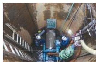
推進工法(立坑内部の様子)
