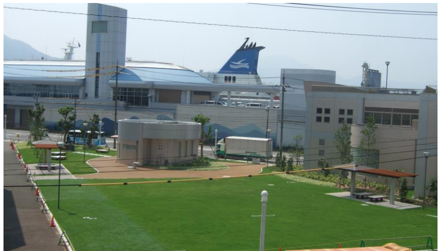
竹崎中継ポンプ場 細江埠頭緑地内に再構築された下水中継ポンプ場
