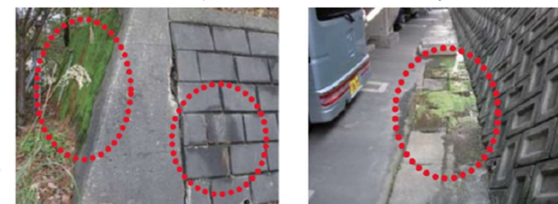
水がしみだしている擁壁 湧水部分にコケが生えている擁壁
