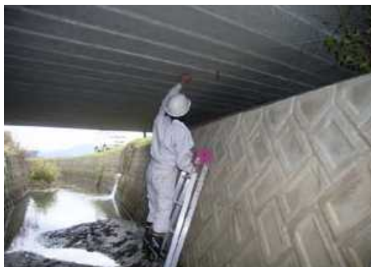
図表51-2) 橋梁の点検の様子
