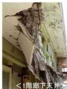
2階の廊下部分が崩落した事例
