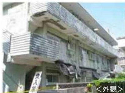
2階の廊下部分が崩落した事例
