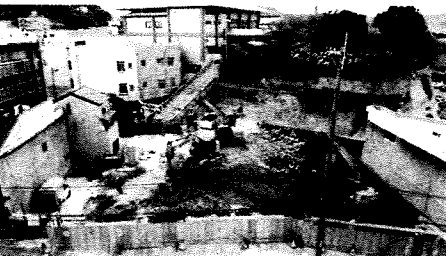
(唐戸はれて解体工事)
