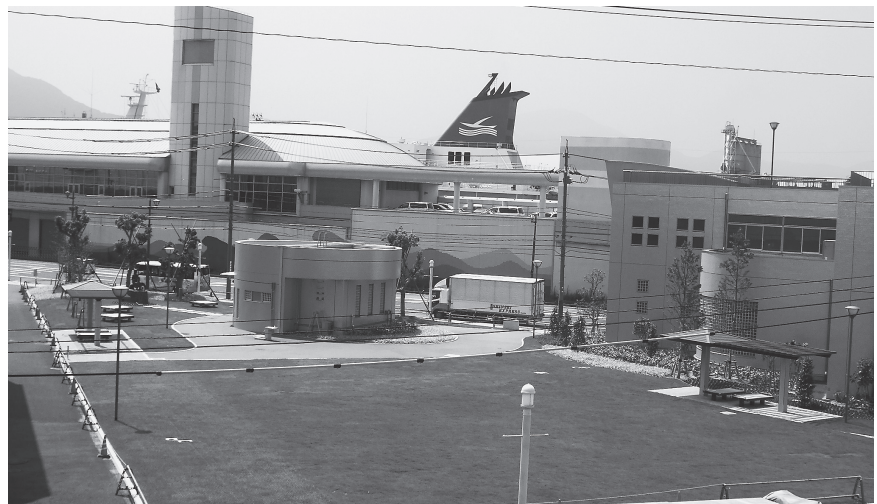
竹崎中継ポンプ場
