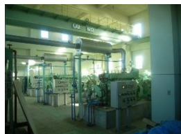
王喜西排水機場
