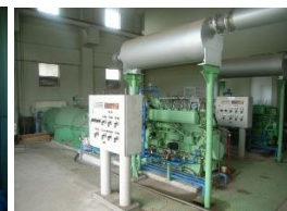
王喜東排水機場
