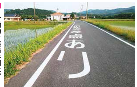
通学路の路面標示例
