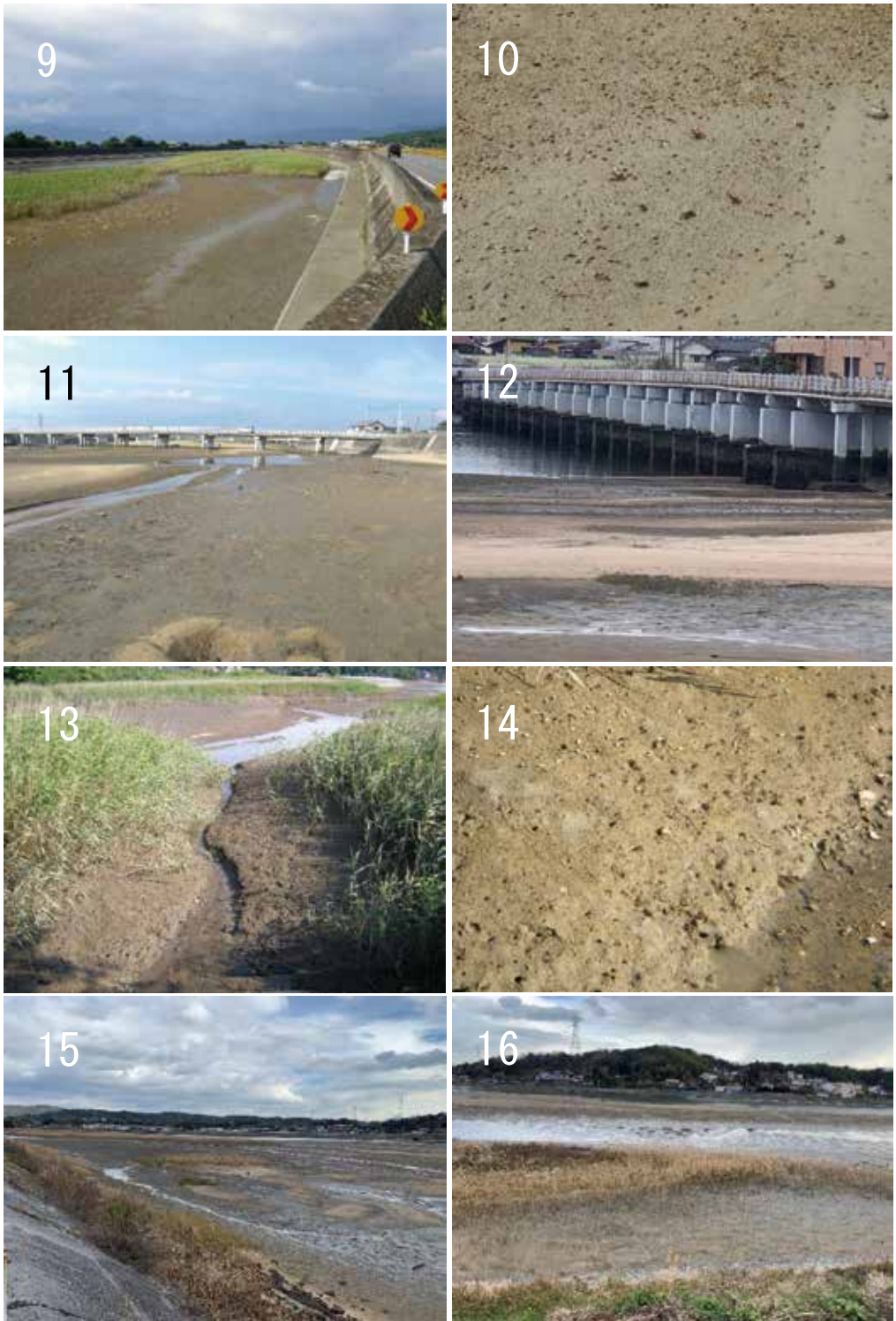
9. No. 14 南若川 (山口市秋穂二島) ; 10. No. 14 南若川 (山口市秋穂二島) ; 11. No. 22 厚東川 (宇部市岩鼻町) ; 12. No. 22 厚東川 (宇部市岩鼻町) ; 13. No. 23 中山川 (宇部市大字沖ノ旦) ; 14. No. 23 中山川 (宇部市大字沖ノ旦) ; 15. No. 24 厚東川 (宇部市大字際波) ; 16. No. 24 厚東川 (宇部市大字際波) .
