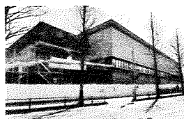
メインアリーナ棟の足場解体されました
