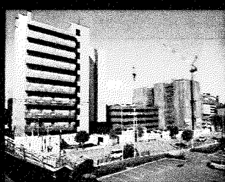
オフィスビルに続きマンション建設が進みます
