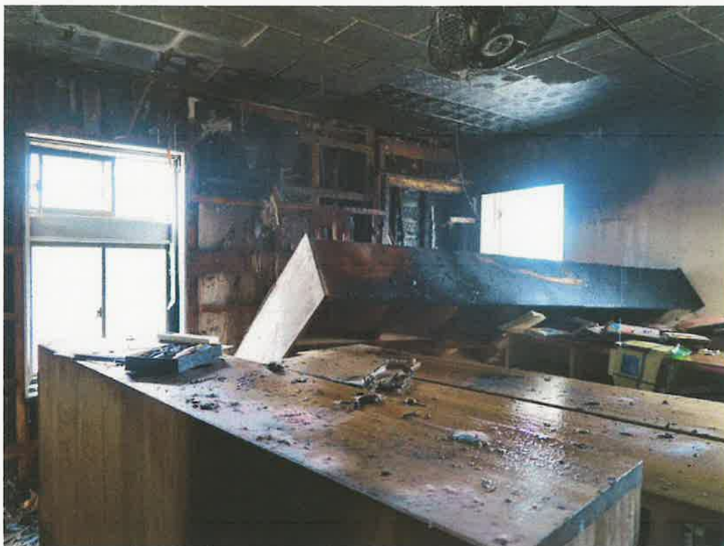
写真 4 めぐみ幼稚園第二園舎 1階室内の状況（図書室）
