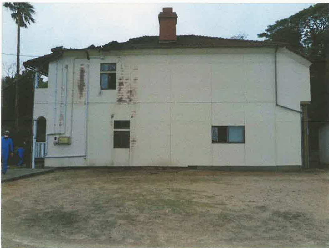
写真 2 めぐみ幼稚園第二園舎 東面外壁
