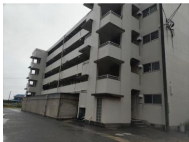
市営長府松原東住宅
