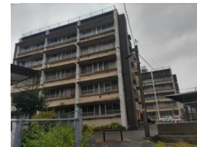
市営長府八幡改良住宅
