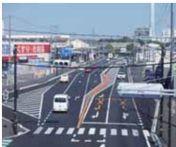
国道2号拡幅整備
