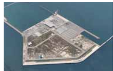
新港地区(長州出島)整備状況
