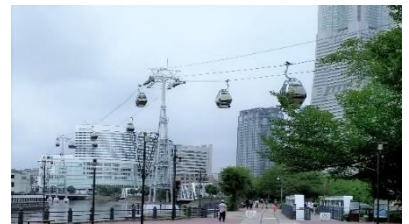
【YOKOHAMA AIR CABIN】 （ロープウェイ）
