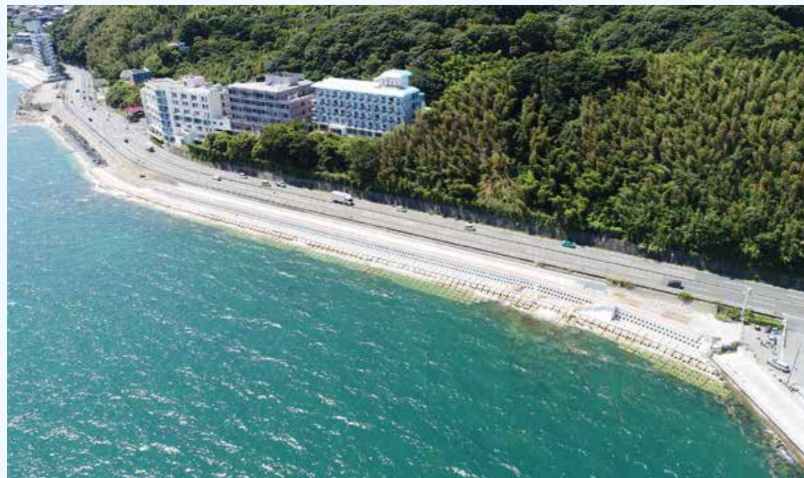
海岸保全施設整備(長府・壇ノ浦地区)
