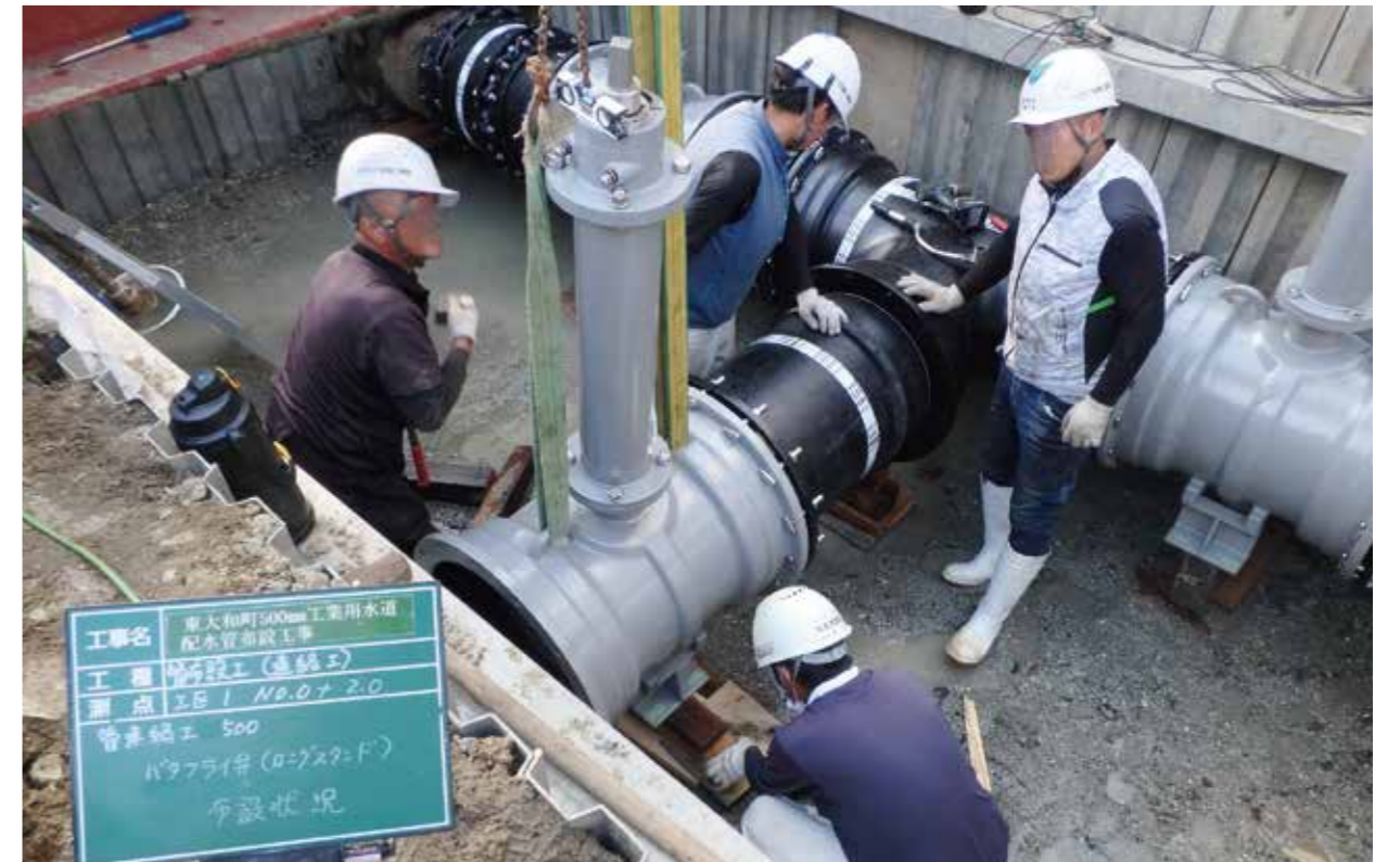
工業用水道配水管路の耐震化
