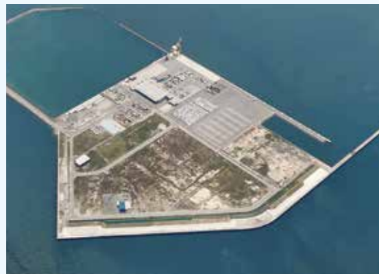
新港地区(長州出島)整備状況
