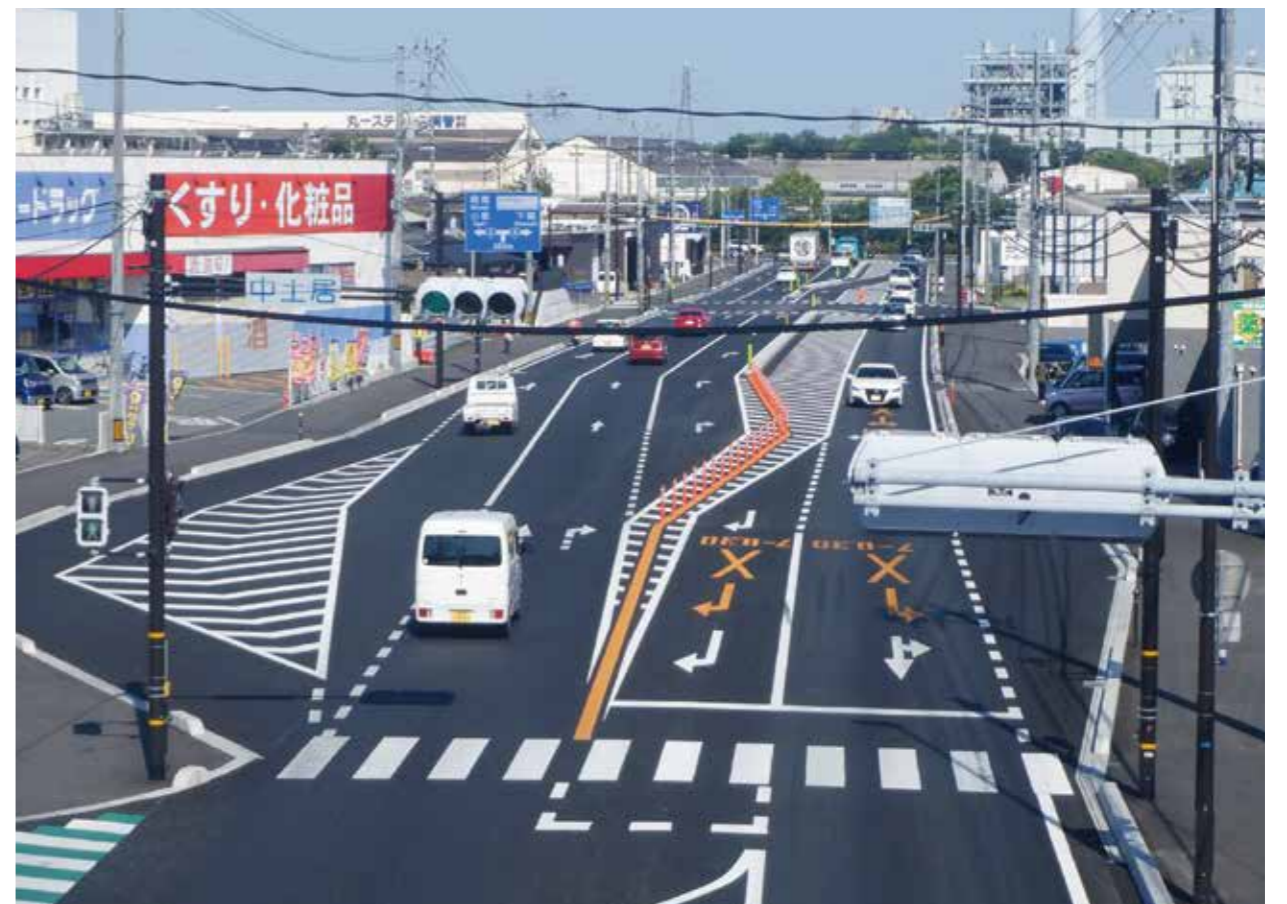
国道2号拡幅整備
