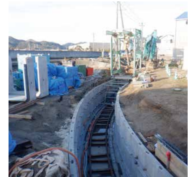
浸水対策のための雨水渠布設工事
