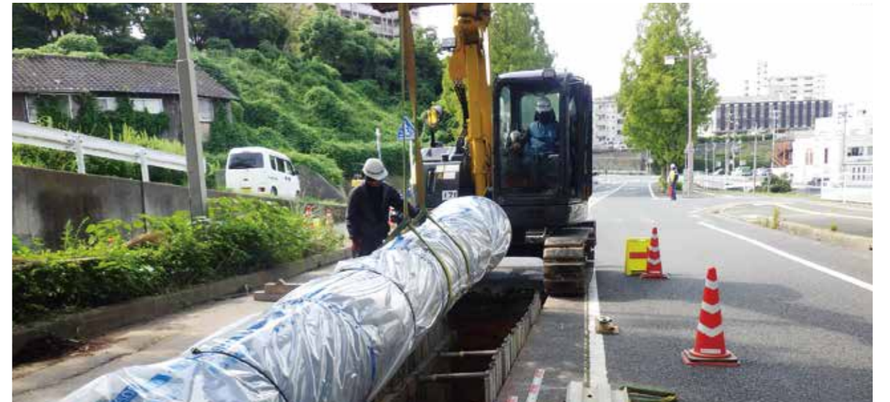
老朽管更新工事
