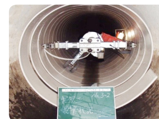
下水道管更生工法（内部の様子） （竹崎町四丁目）
