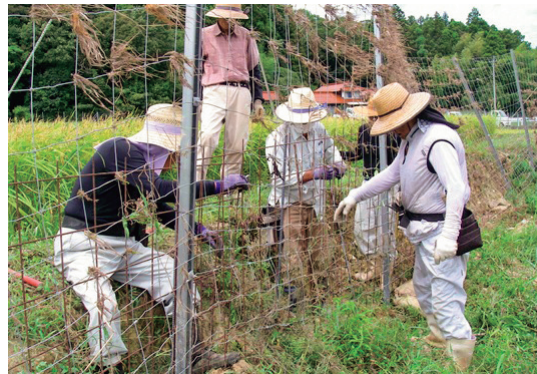
◀防護柵の点検補修 年に2回、すべての防護柵の点検補修を行って、良好な状態を保ちます。
