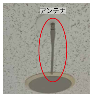
《図2》天井下方向の設置例
