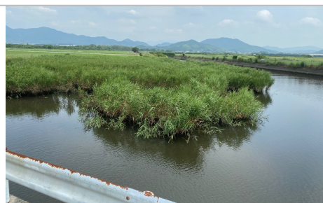
王喜西排水機場遊水池：土砂堆積
