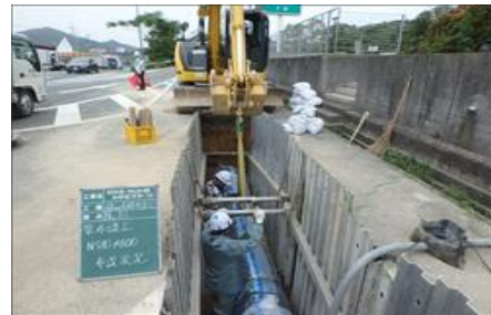
送水管布設工事 長府浄水場～日和山浄水場間（楠乃二丁目）
