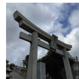
大鳥居 御影石製 高さ 12.7m 幅 15.1m 柱直径 1.2m 日本一と称されている
