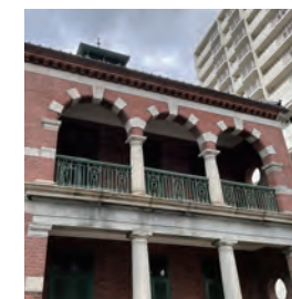
ベランダ 赤煉瓦の円形アーチと白い 石材の丸柱が連続した配置
