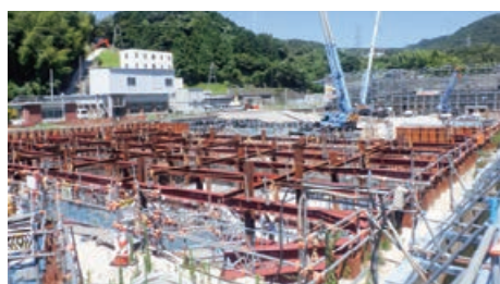
施設更新が進む長府浄水場
