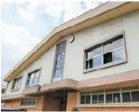
空調設備のない学校体育館
