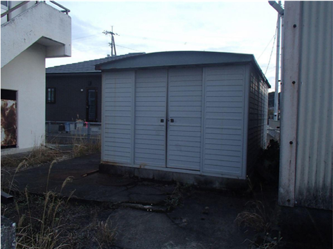
外 観（附属建物4）
