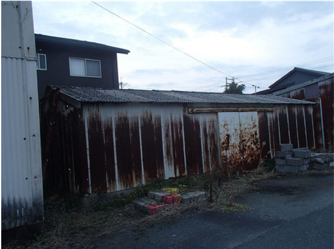
外 観（附属建物6）
