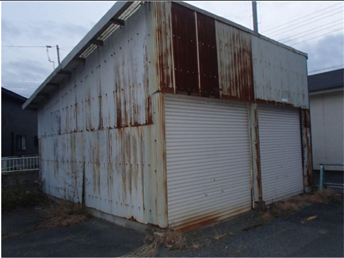
外 観（附属建物9）
