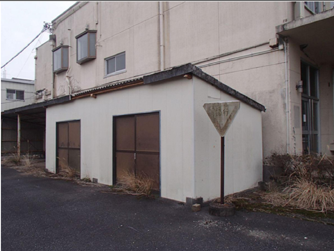
外 観（附属建物3）
