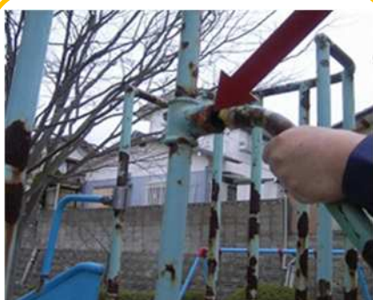
登行部 手すり部分の劣化 (健全度判定“D”)
