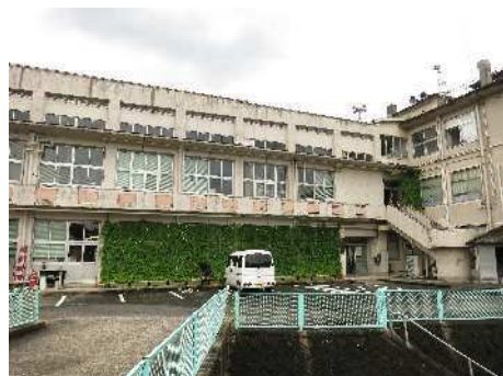
豊田総合支所
